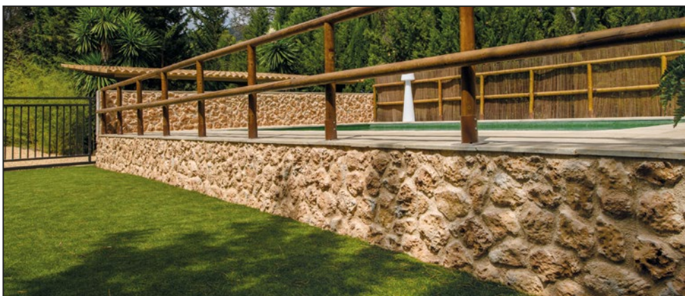
TIMANFAYA castaño rejuntado con MORVER pardo
