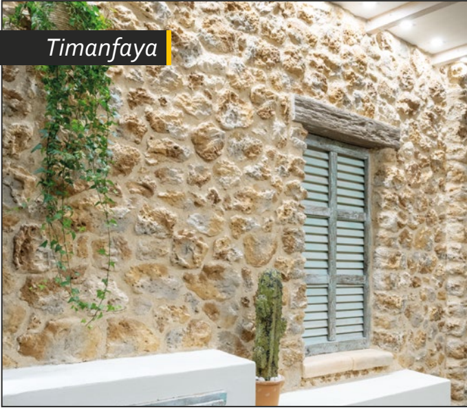
TIMANFAYA castaño rejuntado con MORVER pardo
